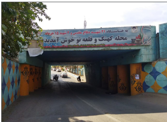
ورودی روستای قلعه نو کهنک- زیرگذر خط آهن
